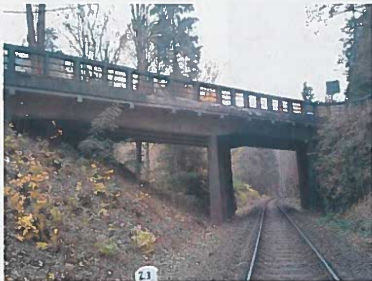
Pohled na most z pravé strany
