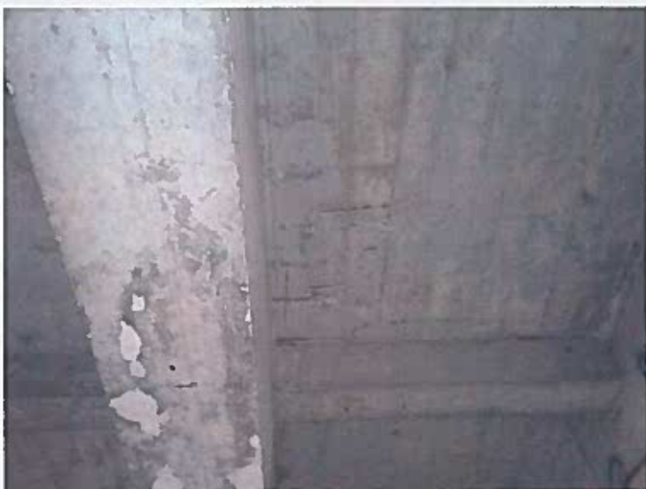
Lokální odpad krycí vrstvy na podhledu NK s korozi odhalené výztuže
