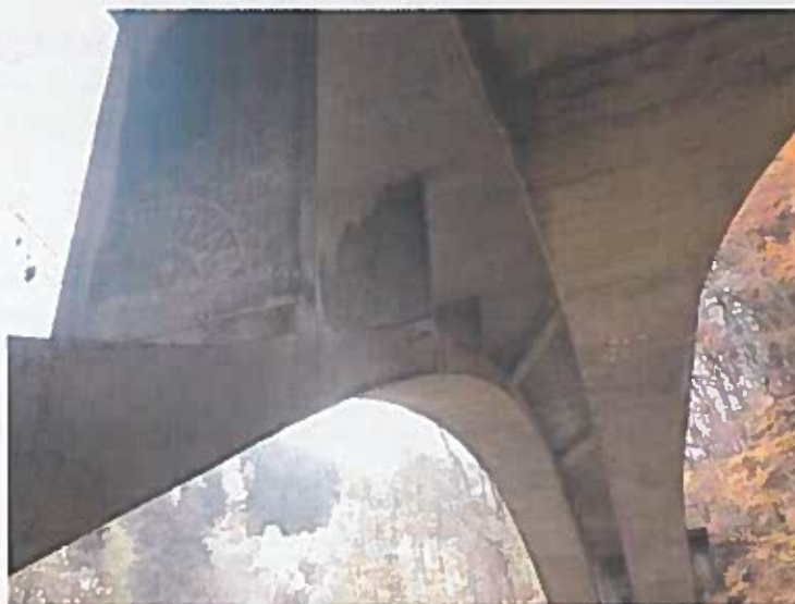
Podhled nosné konstrukce
