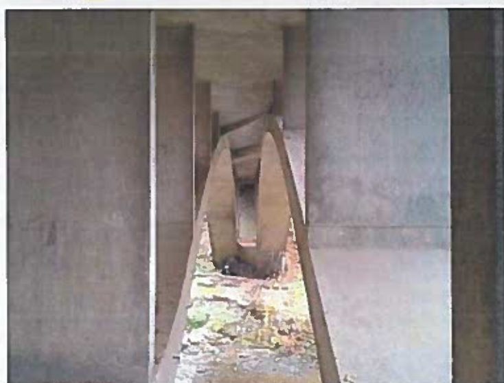
Podhled nosné konstrukce
