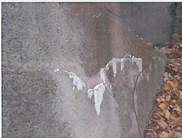
Projevy zatékání pod omítku na základovém bloku na pravobřežní podpěře
