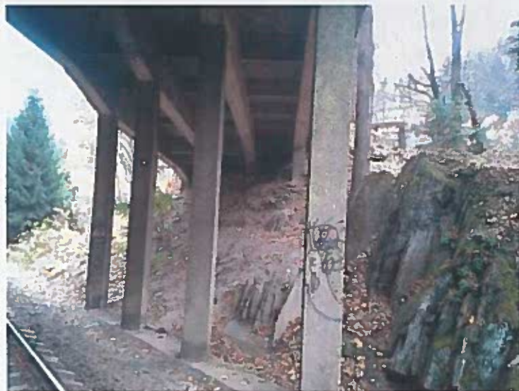
Pohled na vnitřní podpěru 3 a podhled NK
