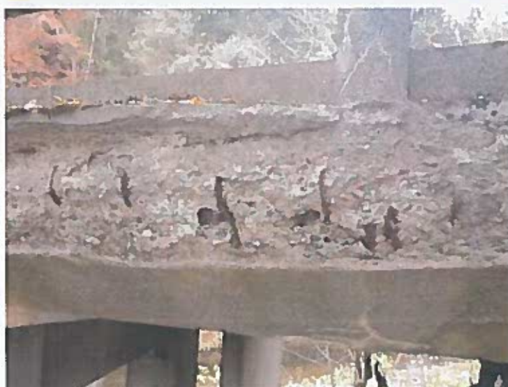
Rozpad okrajů NK / říms
