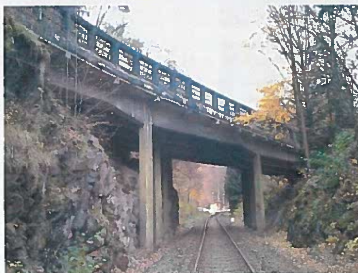
Pohled na most z levé strany
