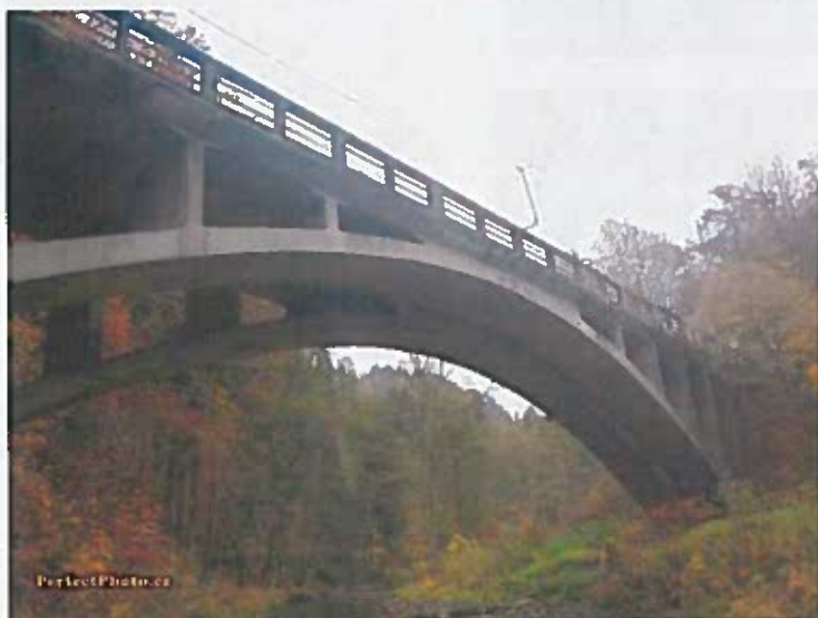
Boční pohled na most - z výtoku
