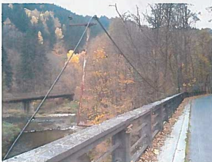
Uspořádání na římse, uchycení sdělovacího kabelu
