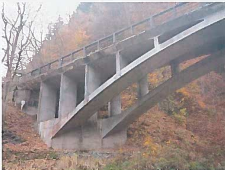
Pohled na pravobřežní opěru
