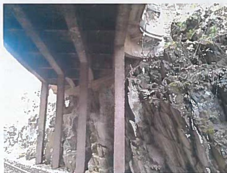
Pohled na vnitřní podpěru 4 a podhled NK
