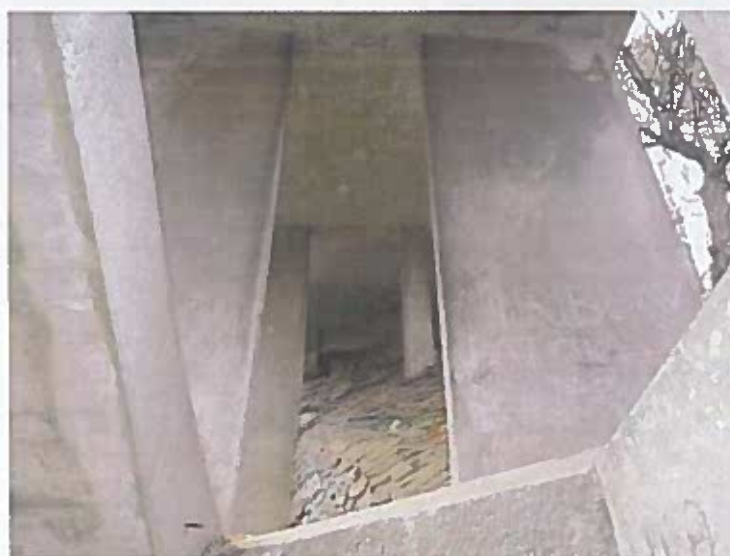
Podhled nosné konstrukce na levobřežní opěře
